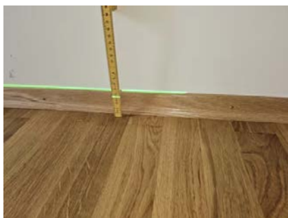
Etasjeskille er kontrollert med nivelleringslaser.
