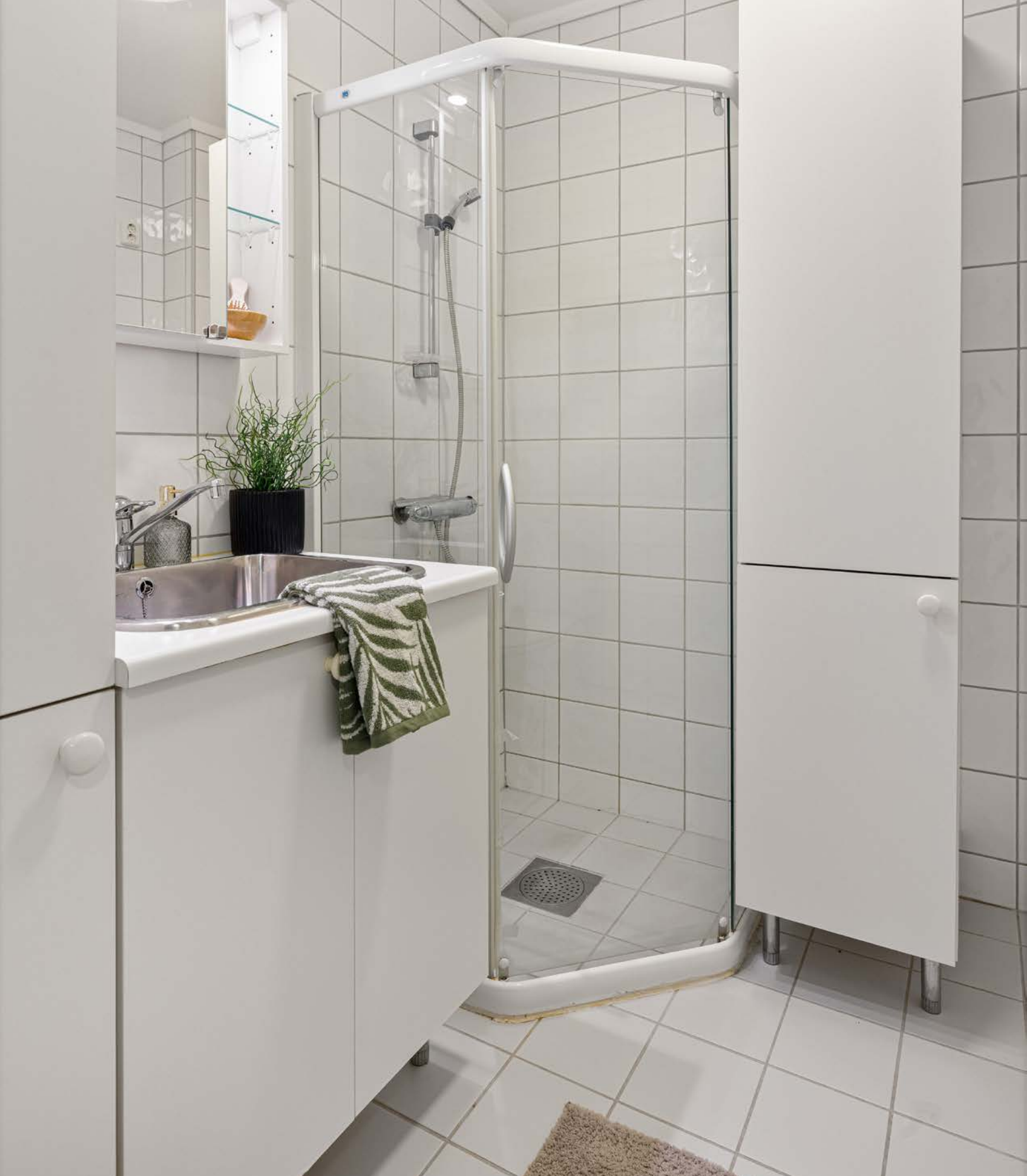
Det er baderomsinnredning med utslagsvask. Speilskap med lys i overkant av vasken.
