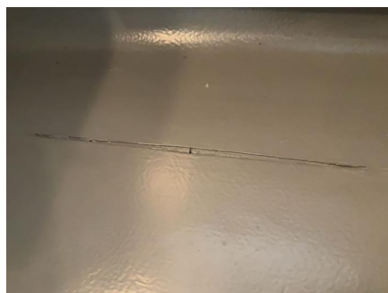
Sprekk i belegg/membran.
