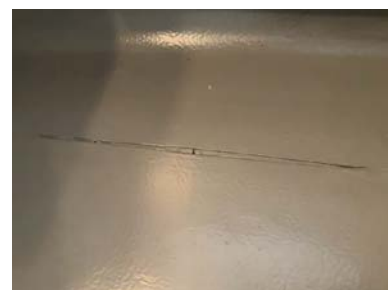
Sprekk i belegg/membran.
