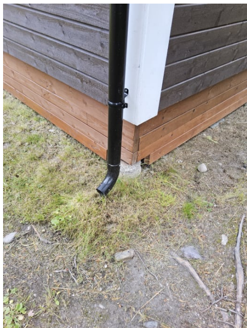
Bilde viser taknedløp.
