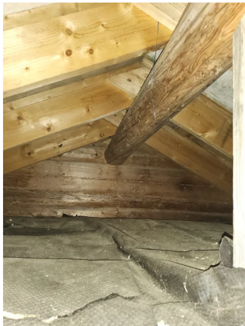
Bilde viser del av kaldtloft.
