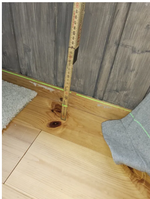
Bilde viser måling av etasjeskiller.
