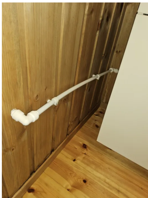
Bilde viser vannrør.
