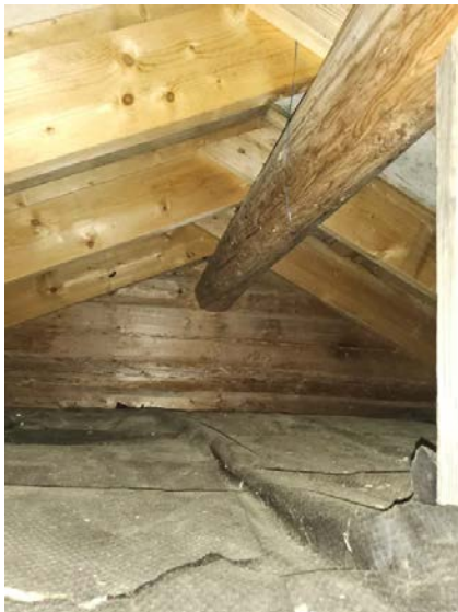
Bilde viser del av kaldtloft.
