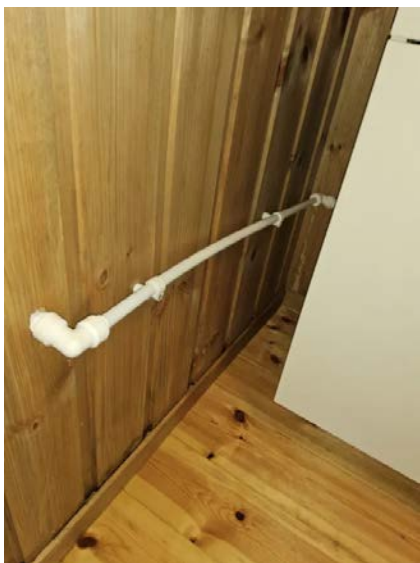
Bilde viser vannrør.
