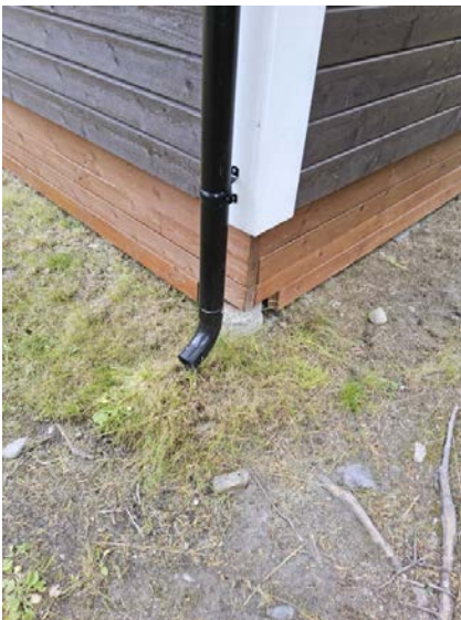
Bilde viser taknedløp.
