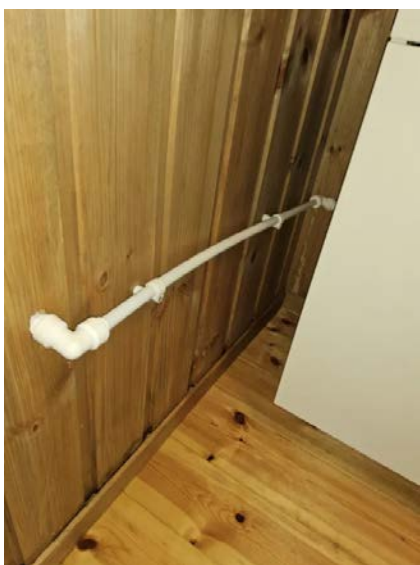
Bilde viser vannrør.
