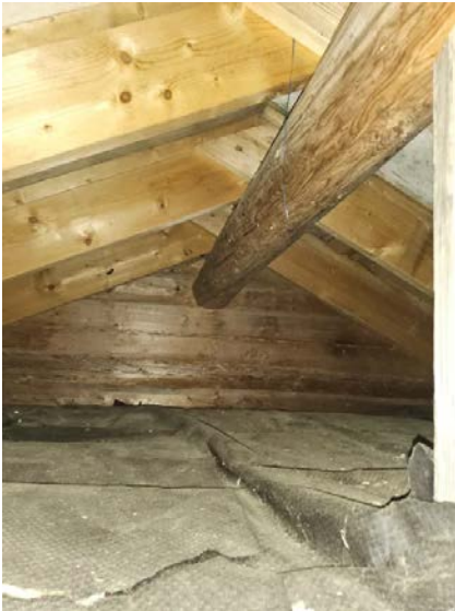
Bilde viser del av kaldtloft.
