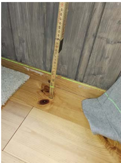
Bilde viser måling av etasjeskiller.
