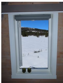
Rømningsvindu på ett av soverommene i 2.etg.
