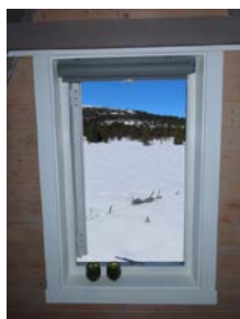
Rømningsvindu på ett av soverommene i 2.etg.
