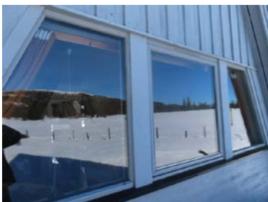
Vinduer fra byggeår - fastkarm samt åpningsvindu i midtparti.
