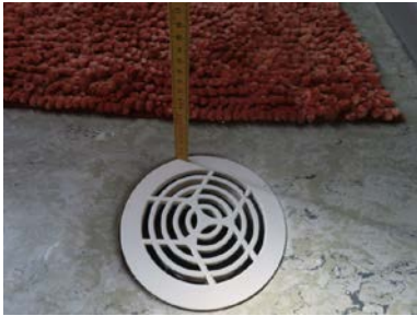
Slik med belegget klemt under klemring.
