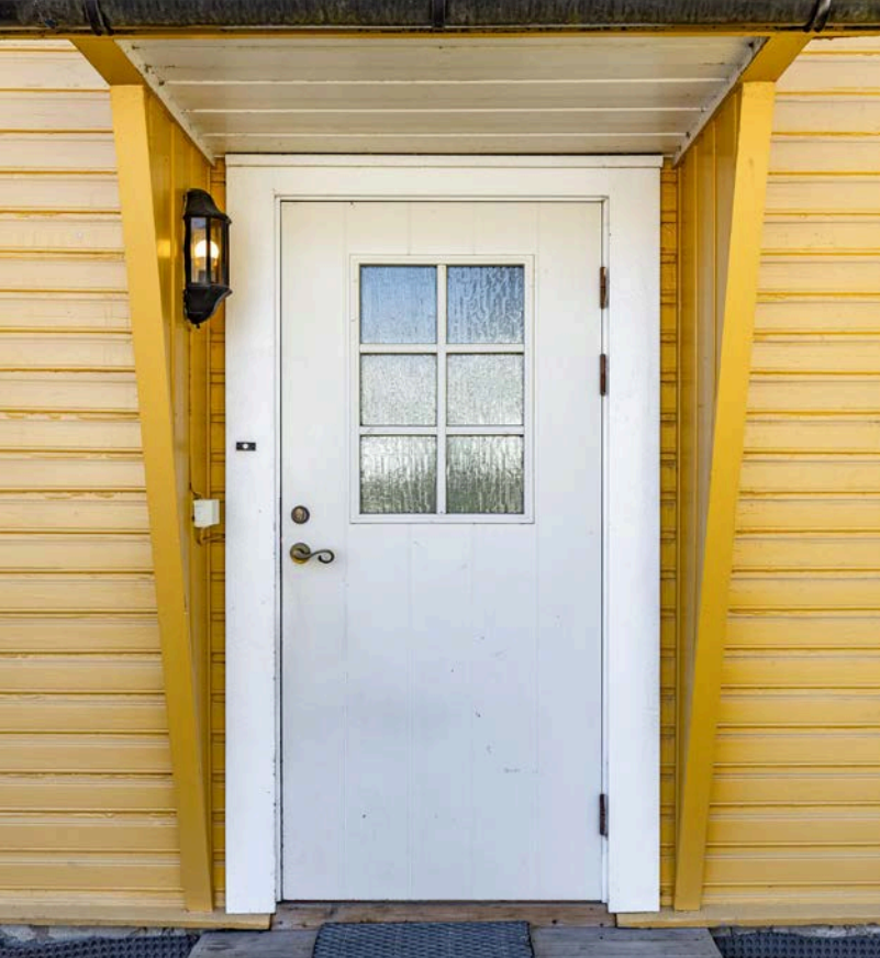
Inngangspartiet som ligger innerst på eiendommen.
