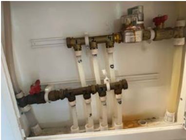
Samleskap med rørkurser og stoppekraner
