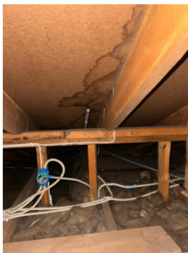
Fuktskjolder i sutakplater ellers
