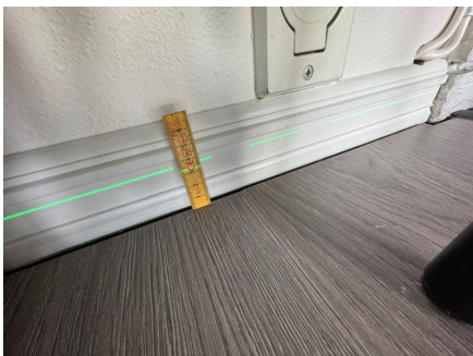
Måling ved veggen mot kjøkkenet.
