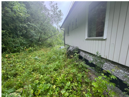
Relativt flatt terreng på baksiden.
