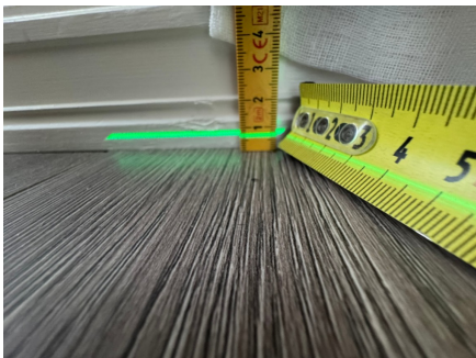
Måling ved altandøren.
