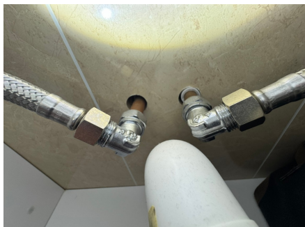
Utette rørgjennomføringer.
