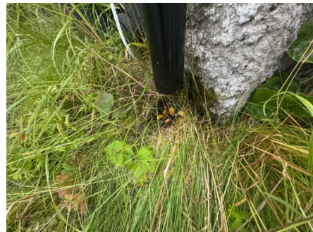
Nedløp som er avsluttet over terreng.
