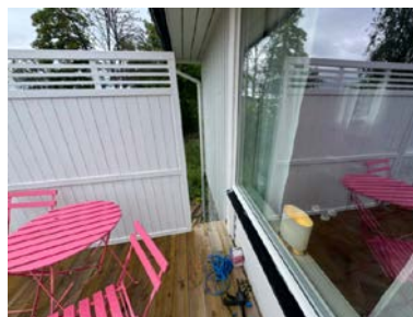
Åpning i rekkverket.
