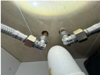
Utette rørgjennomføringer.
