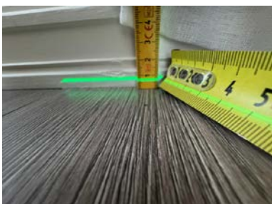
Måling ved altandøren.
