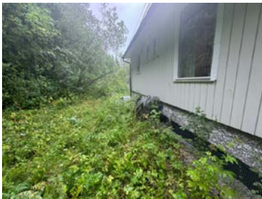
Relativt flatt terreng på baksiden.
