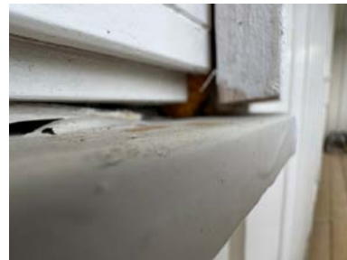
Det er ikke oppbrett på beslaget samt at det har lite fall.
