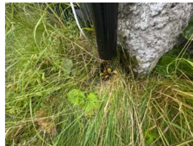
Nedløp som er avsluttet over terreng.
