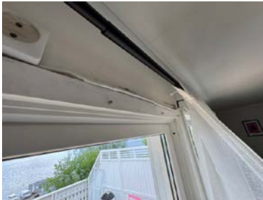
Eksempel på løse ledninger.
