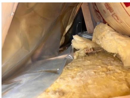
Plast bak knevegger, ikke fagmessig montert
