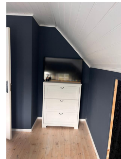
Innkledte sider på pipe på soverom.
