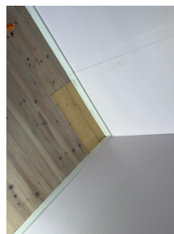
Åpning i gulv er utbedret etter befaringen
