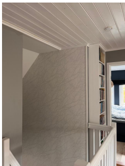
Innkledte sider på pipe på stue 2 etasje
