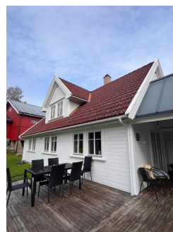
Kledning helt ned på terrassegulv.
