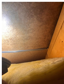
Plast bak knevegger, ikke fagmessig montert
