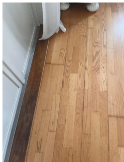
Merker etter fukt i skjøter ved balkongdør.
