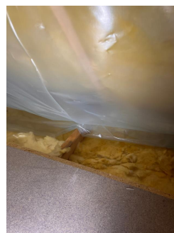
Plast bak knevegger, ikke fagmessig montert
