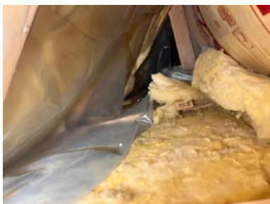
Plast bak knevegger, ikke fagmessig montert
