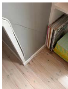
Merker etter fukt i skjøter ved balkongdør.
