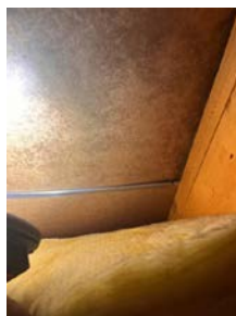
Plast bak knevegger, ikke fagmessig montert
