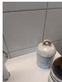
Hull i flis tettet etter befaringen
