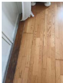
Merker etter fukt i skjøter ved balkongdør.
