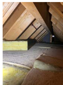
Plast bak knevegger, ikke fagmessig montert
