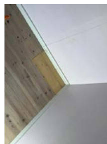
Åpning i gulv er utbedret etter befaringen
