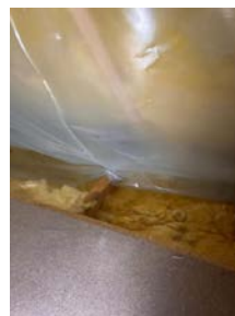
Plast bak knevegger, ikke fagmessig montert
