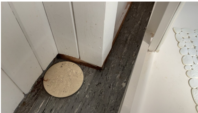
Det er ikke tettesjikt i overgang gulv/vegg
