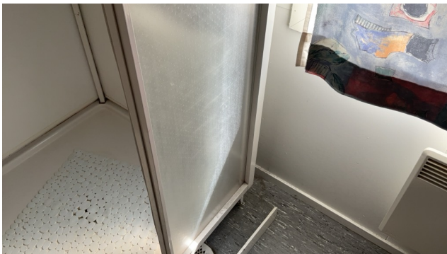
Det er ikke tettesjikt i overgang gulv/vegg
