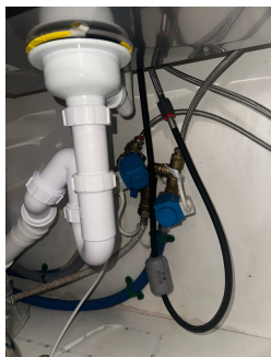
Røropplegg i kjøkkenbenk med Waterguard
