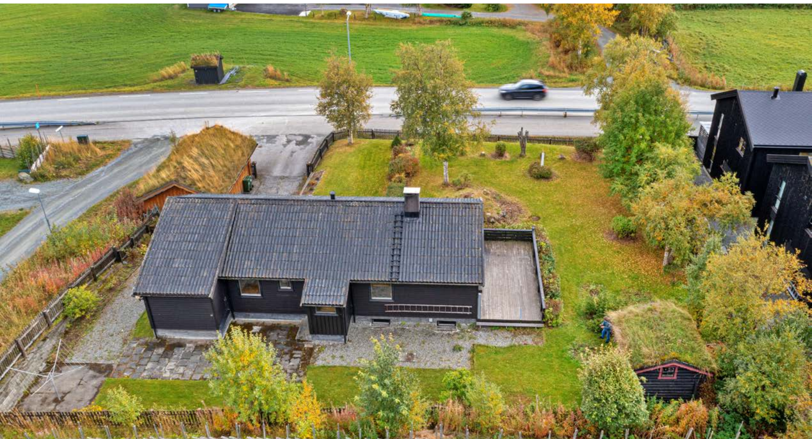
Eiendommens bebyggelse består av enebolig samt frittstående garasje og stabbur
