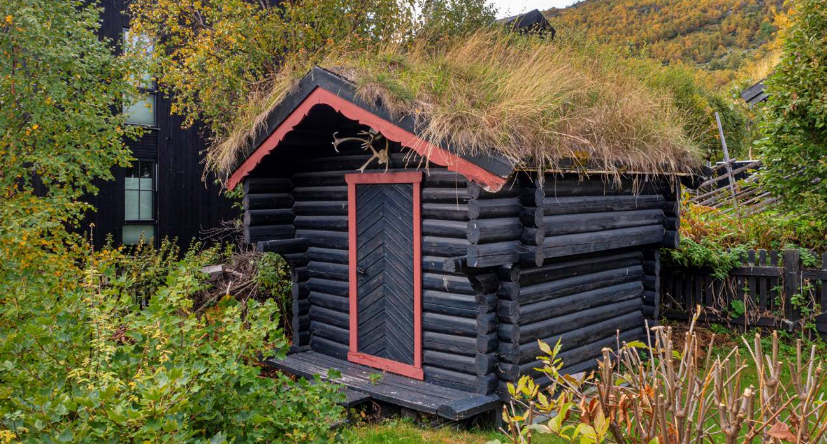
Frittstående stabbur i hjørnet av tomten mot nordvest
