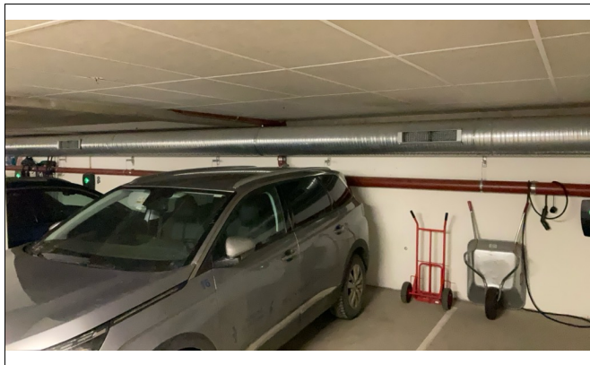
Biloppstillingsplass i kjelleretasjen.
