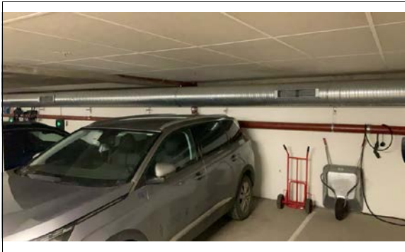
Biloppstillingsplass i kjelleretasjen.
