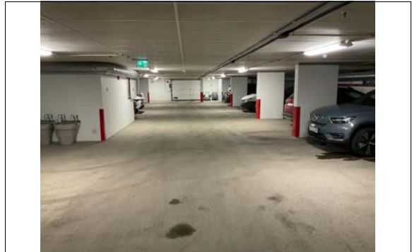
Felles garasjeanlegg i kjelleretasjen.
