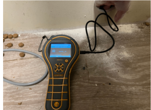
Det ble ikke målt unormale fuktverdier i konstruksjoner.
