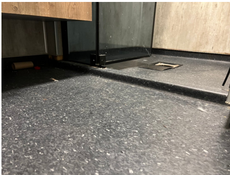
Det er laget oppkant mot dusjsone.
