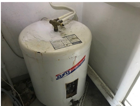
Defekt varmtvannsbereder.
