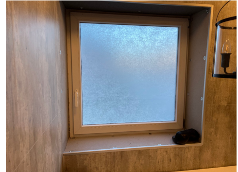
Synlige litexplater som foringer i vindu ved badekar.
