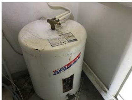
Defekt varmtvannsbereder.
