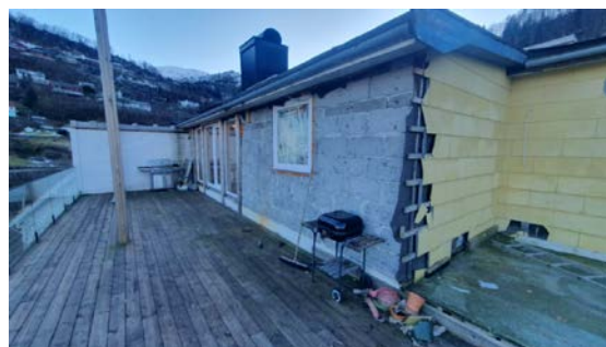
Uferdige arbeider. Dels fasade i upusset leca, dels fasade med eternittplater.
