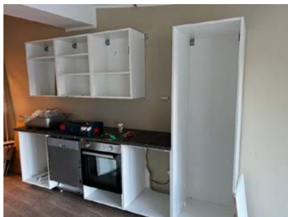
Kjøkkeninnredningen er ikke ferdig motnert.
