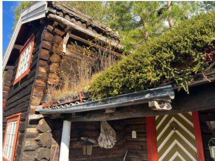
Takrenne ved inngang til stue.
