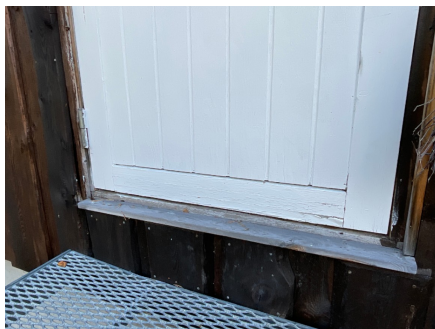
Malingsslitasje hovedinngangsdør.
