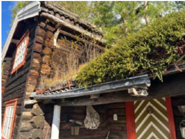
Takrenne ved inngang til stue.
