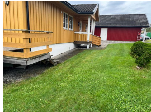
Terreng skråner lett fra øst mot bygning.
