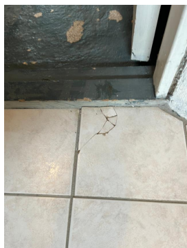
Salutslag, løs puss og indikasjon på fukt ved fuktsøk.
