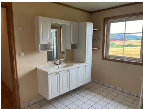
Tapet på vegger i våtsoner.
