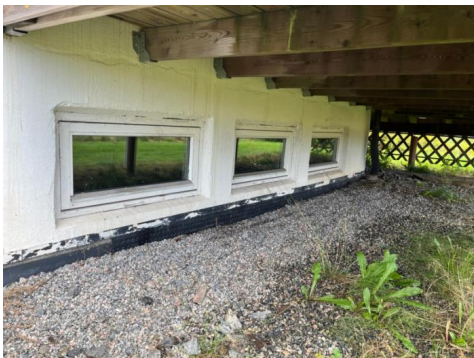
Synlig grunnmursplast mot vest.
