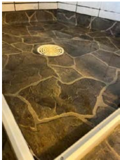
Vannest viste at bruksvann ikke renner til sluk.
