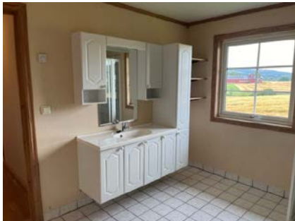
Tapet på vegger i våtsoner.
