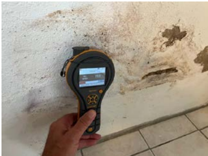
Salutslag, løs puss og indikasjon på fukt ved fuktsøk.
