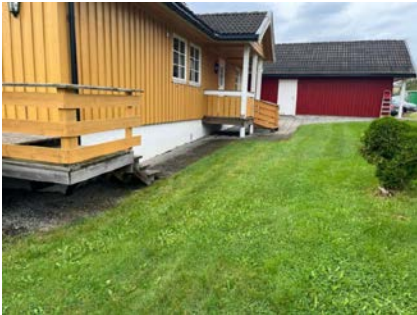
Terreng skråner lett fra øst mot bygning.
