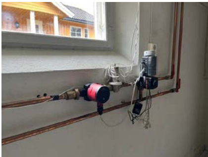
Styring for vannbåren varme til nabohus.
