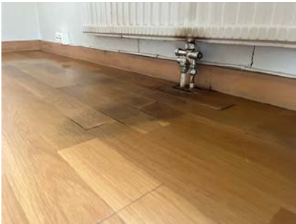
Fuktskader på gulv og vegger lekkasje fra radiator.
