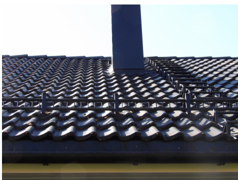
Inndekket pipe over tak.
