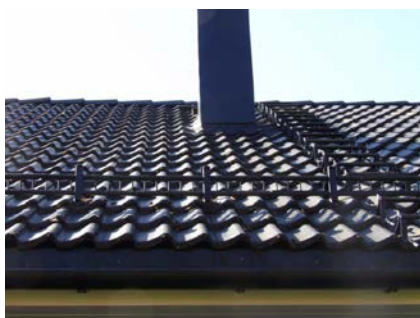
Inndekket pipe over tak.
