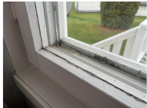
Koblede vinduer i 1. etasje.
