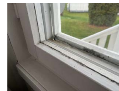
Koblede vinduer i 1. etasje.
