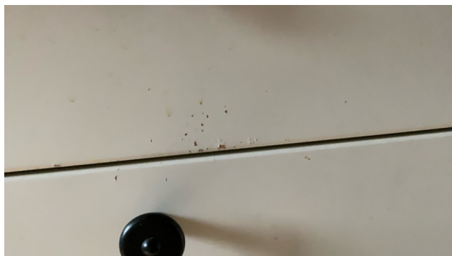
Eksempel på skader/sår i kjøkkenfronter.
