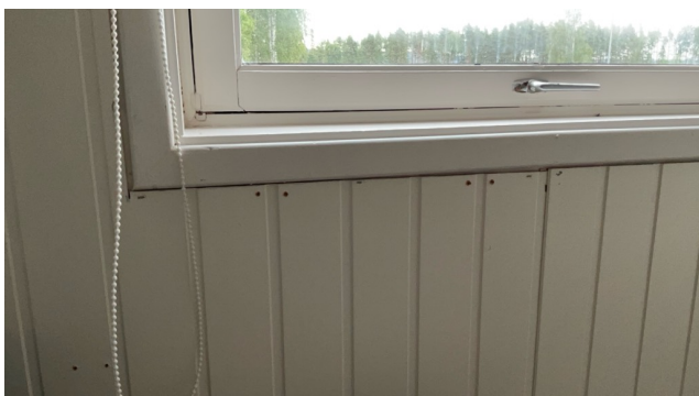
Ufagmessig utførelse på plater/listeverk
