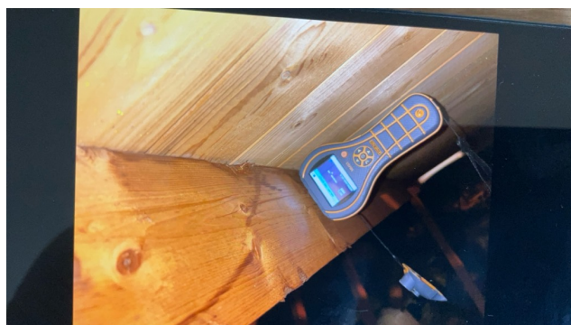
Fuktmåling i fuktskjolder uten unormale resultater.
