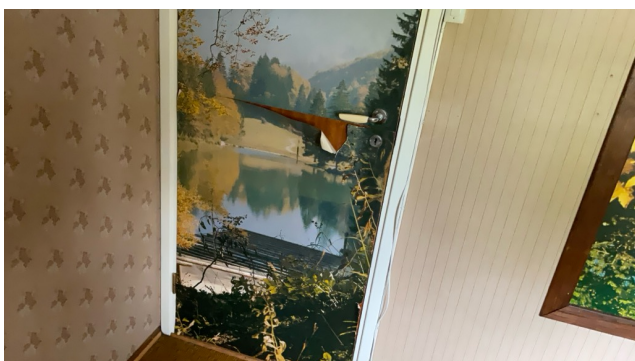
Eksempel på at tapet løsner fra dørblad.
