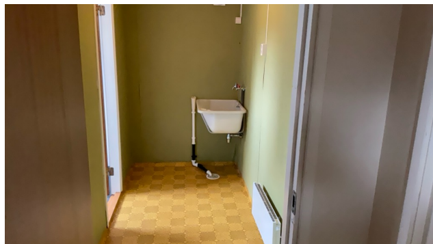
Vaskerom trolig fra byggeår.
