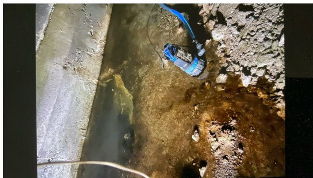
Eksempel på vann i krypkjeller.
