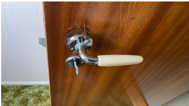
Løs dørrvrider og riper i dørblad.
