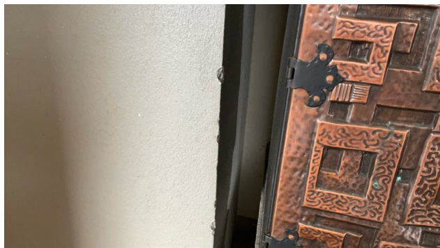
Hjørne på pipe har pussavskaling.
