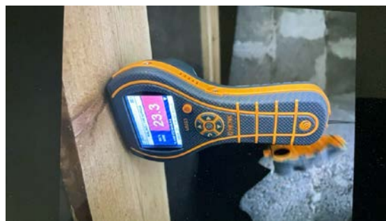
Eksempel på fukt i treverk.
