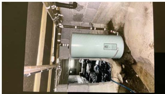
Bereder monter i krypkjeller.
