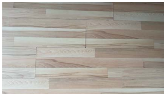
Eksempel på at laminat går opp i skjøter.
