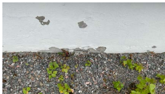
Eksempel på løs puss på grunnmur.
