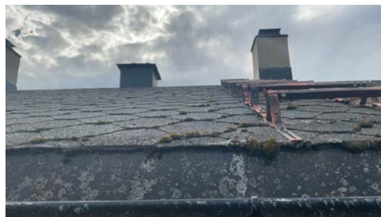
Eksempel på mose på takteking.
