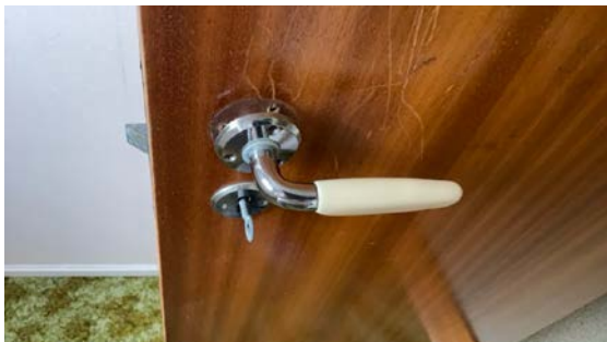
Løs dørrvrider og riper i dørblad.
