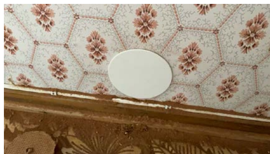
Hull forsvarlig plombert.
