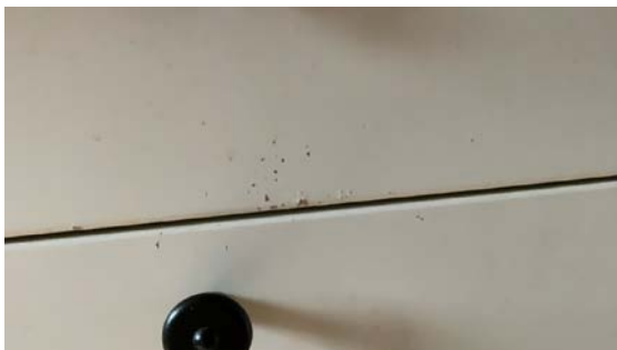
Eksempel på skader/sår i kjøkkenfronter.
