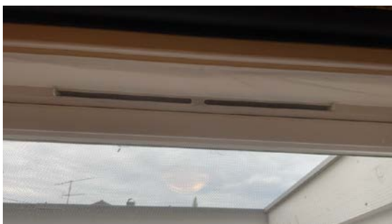
Ventiler i vindu.
