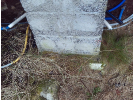
Ligger jordmasser inntil pilarer.
