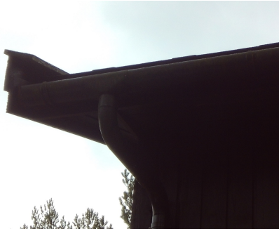
Takrenner og nedløp av plast.
