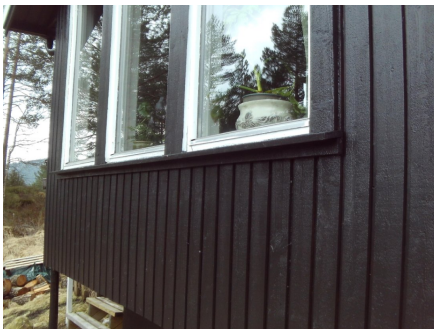
Deler av ene fasaden med tilhørende belistninger.
