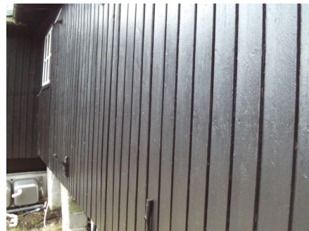
Kledningen er blitt bra vedlikeholdt.
