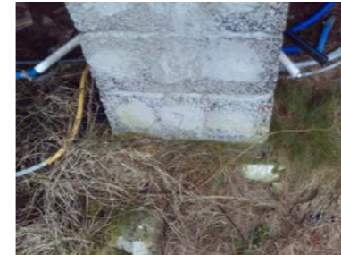
Ligger jordmasser inntil pilarer.
