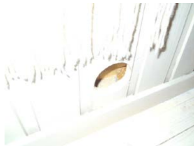
Hulltaking i fra gangen.
