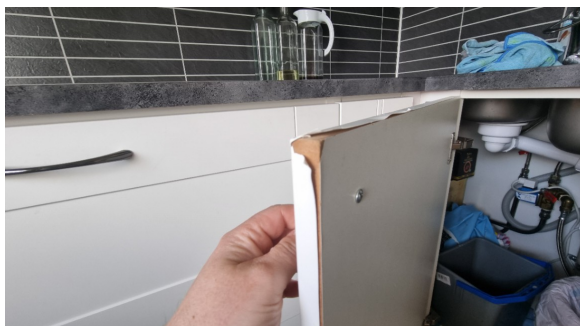
Det er skade på skapfront.
