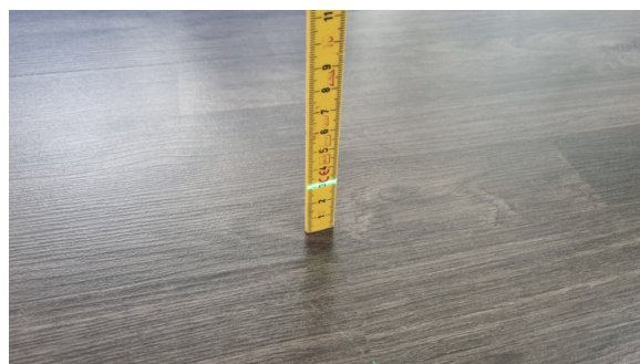
Kontroll av planavvik.
