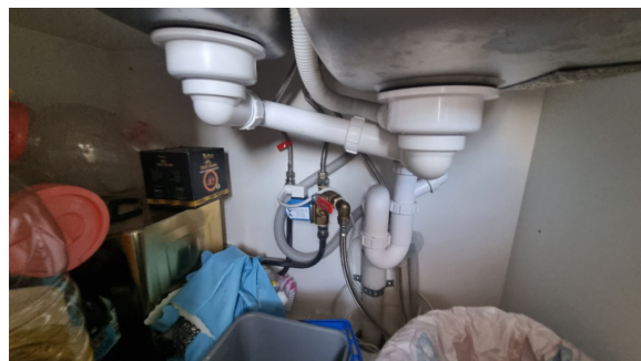
Det er montert Waterguard.
