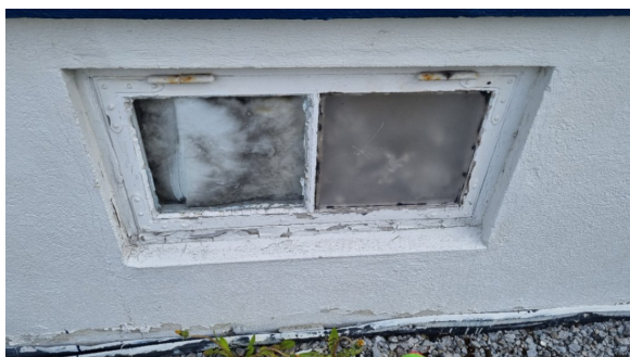
Vinduer fra byggeår i kjelleretasjen.
