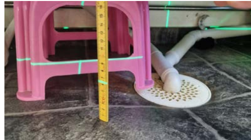
Gulvet har fall mot sluk.
