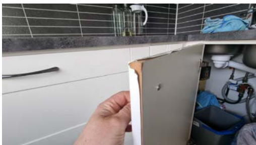
Det er skade på skapfront.
