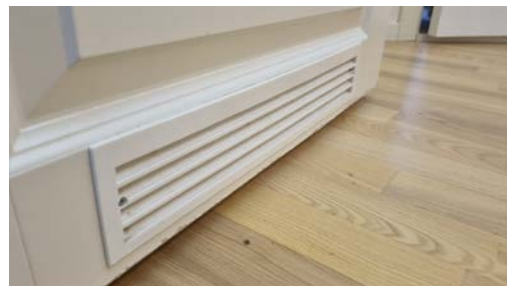
Tilluft via luftspalte i dørblad.
