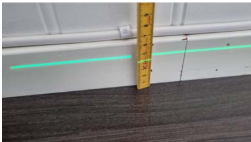
Kontroll av planavvik.
