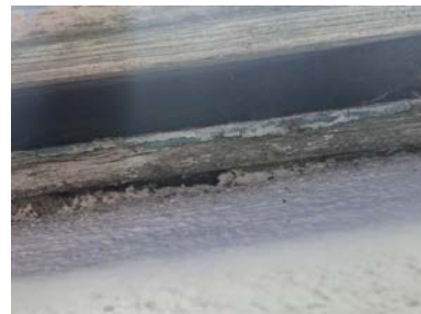
Det er registrert 2-lag med bordkledning
