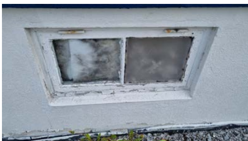
Vinduer fra byggeår i kjelleretasjen.
