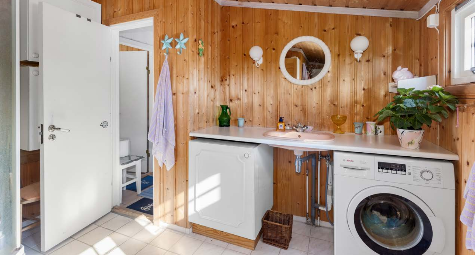
Bad/vaskerom med servant, opplegg til vaskemaskin og dusjkabinett.
