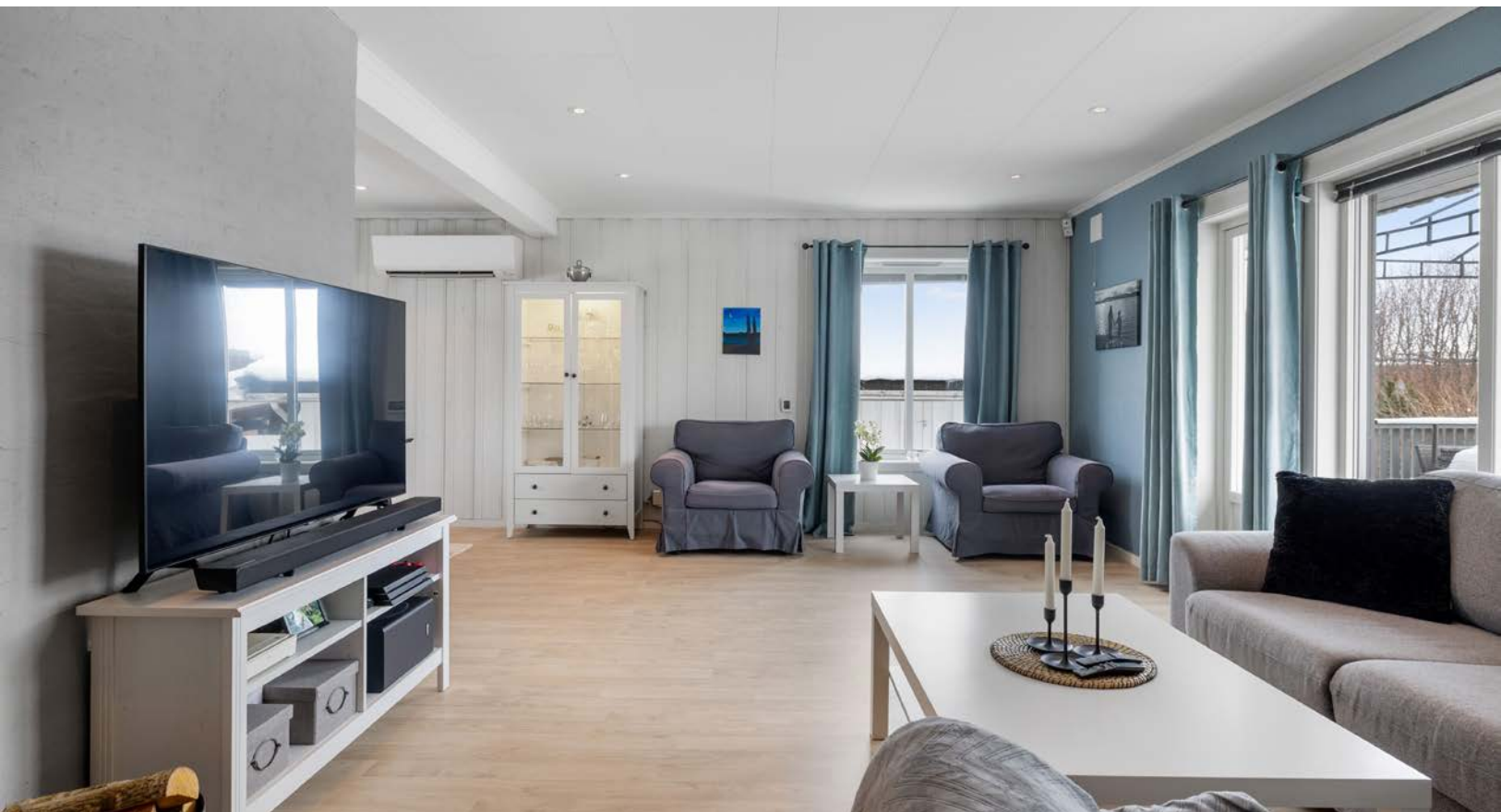
Det er lagt laminat på gulvet i stua i 2017/2018 og veggene har en kombinasjon av malt panel og malte mdf-plater. I himlingen er det downlights som sørger for jevn og god belysning.
