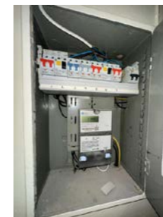
Sikringskap med automatsikringer.
