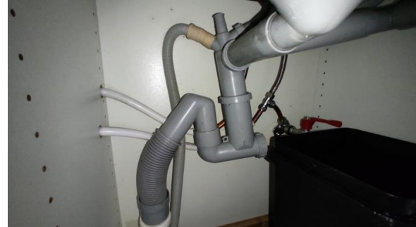
Kontroll av røropplegg.
