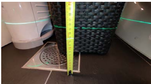
Kontroll av fallforhold.
