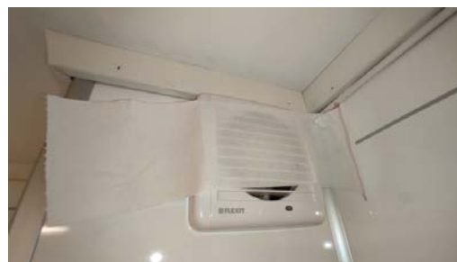
Test av avtrekket.
