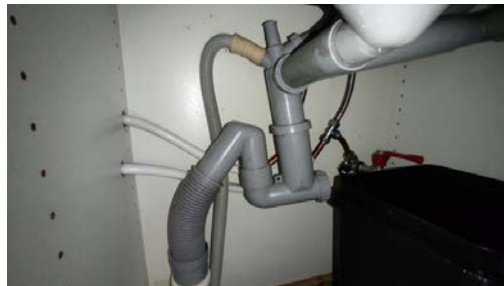
Kontroll av røropplegg.
