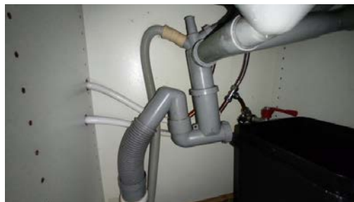
Kontroll av røropplegg.
