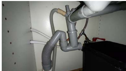
Kontroll av røropplegg.
