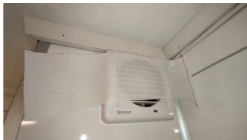
Test av avtrekket.
