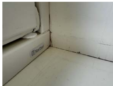
Noen bruksmerker i vinduskarmer.
