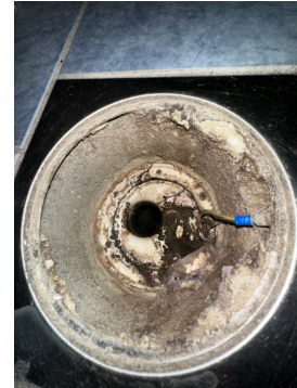
Plastsluk med klemring for membran
