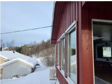
Montert screen på stuevinduer
