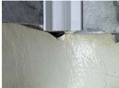
Belegg er ikke lagt bak baderomsplater
