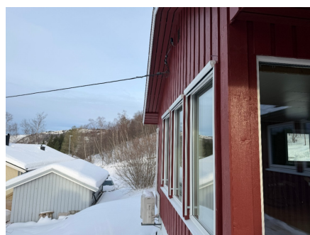
Montert screen på stuevinduer
