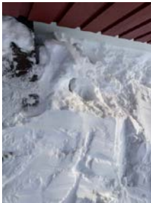
Trappen var snødekt ved befaring.
