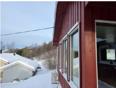
Montert screen på stuevinduer
