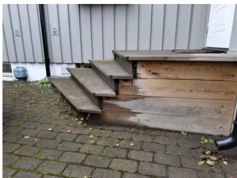
Hovedparten av boligens grunnmur er tildekket av trapp og terrasse.
