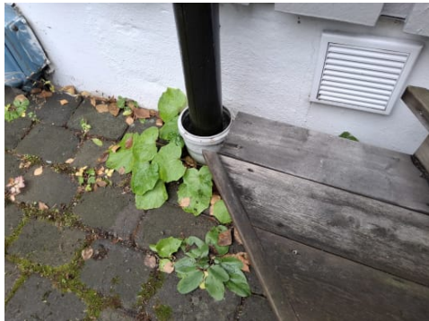
Taknedløp er avsluttet i eget rør.
