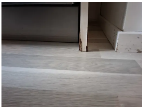
Svelleskadet dekkside.
