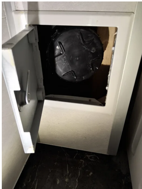
Stakeluke er plassert i kasse på bad i kjeller.
