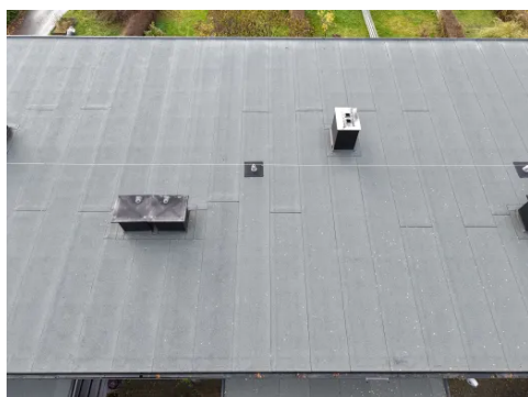
Taket er tekket med asfaltpapp.
