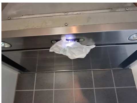
Avtrekkseffekten er testet med papir.
